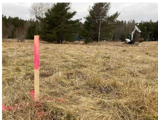
Bild 6. Vy vid provpunkt 22W10
